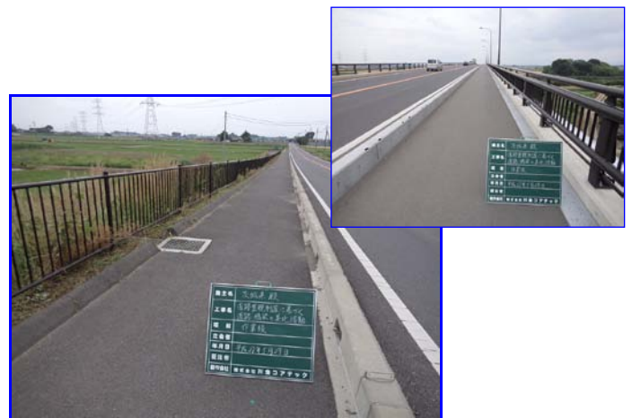
作業後の歩道部
